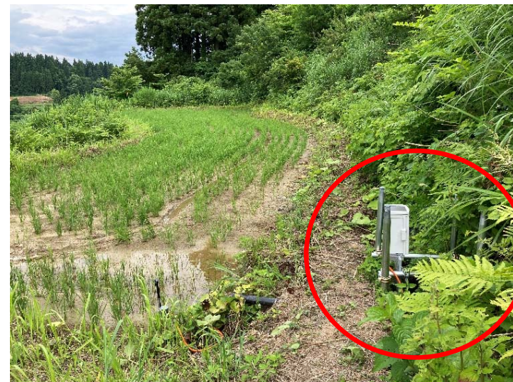
自動給水栓の設置（新潟県十日町市まつだいの棚田）
